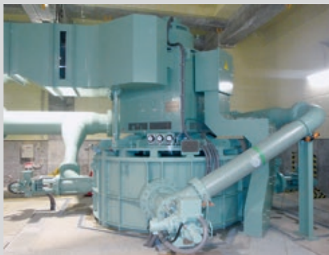
Turbine de Makayabaru (Japon), 3 injecteurs (Q = 0.730 m 3 /s, Hn = 176 m, Pm = 1132 kW)
