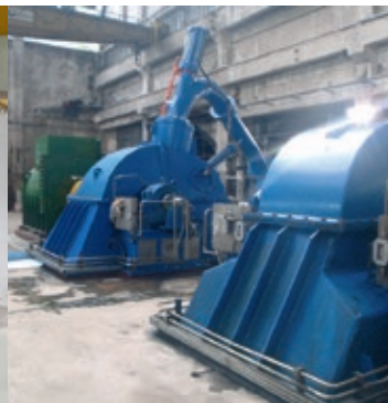
Turbines de La Gorge (F), axe horizontal, 2 injecteurs (Q = 0.900 m 3 /s, Hn = 440 m, Pm = 3490 kW)
