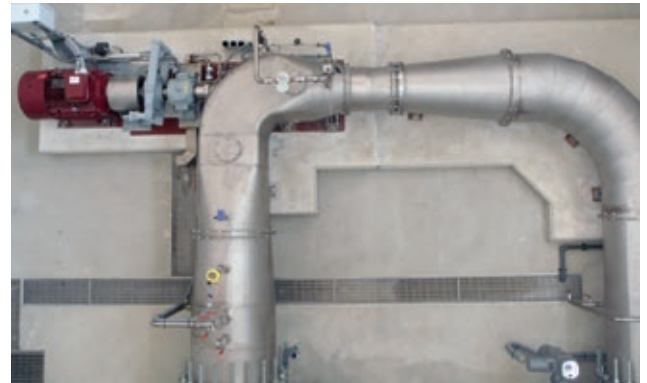
Turbine Axiale à axe horizontal utilisant l'eau potable d'Arezzo ( Q = 0.380 \text{ m}^3/\text{s} , H_n = 12.5 \text{ m} , P_m = 42 \text{ kW} )
